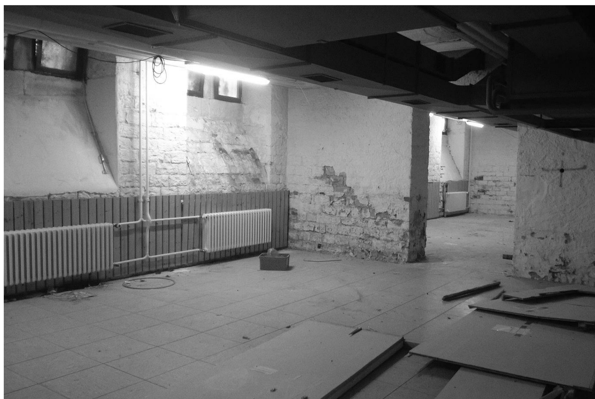
Speisesaal vor der Baumaßnahme
