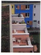
strich aus und zum anderen fallen kleinere Beschädigungen an der Fassade optisch nicht ins Auge. Der abschließende Deckanstrich erfolgte mit Keim-Egalisationsfarbe auf Silikatbasis.
