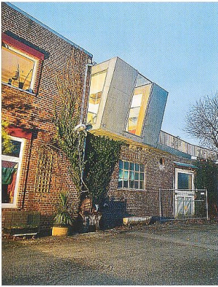
LIFT-Wohnraumerweiterung, Mönchengladbach Platzhalter Architektur, A-Wien
