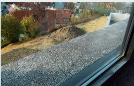
Blähton wurde als leichte Gesteinskörnung eingesetzt.
