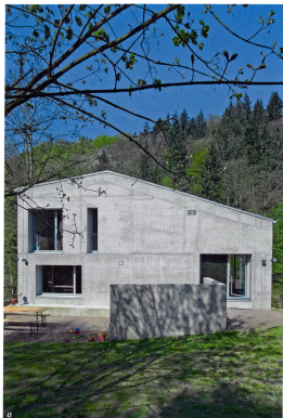
Abb. 1.51: Aus Ortbeton wurde dieses monolithische Wohnhaus gebaut. Die Außenwände und das Dach bestehen aus 0,50 m dickem Isolationsbeton; eine zusätzliche Wärmedämmung war deshalb nicht erforderlich. Die Wände zeigen ganz bewusst die Materialität des Isolationsbetons: Lunker, Kiesnester, Wolkenbildung, Schalungsstäbe und Ausbruchstellen sollten sichtbar bleiben und ein Teil der Innenraumgestaltung sein.
