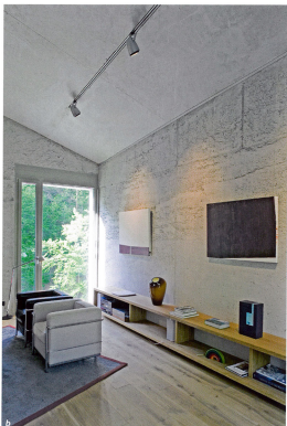
Abb. 1.51: Aus Ortbeton wurde dieses monolithische Wohnhaus gebaut. Die Außenwände und das Dach bestehen aus 0,50 m dickem Isolationsbeton; eine zusätzliche Wärmedämmung war deshalb nicht erforderlich. Die Wände zeigen ganz bewusst die Materialität des Isolationsbetons: Lunker, Kiesnester, Wolkenbildung, Schalungsstäbe und Ausbruchstellen sollten sichtbar bleiben und ein Teil der Innenraumgestaltung sein.
